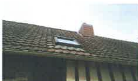
Tolure : Bardages conduit de cheminée en ardoises amiante ciment
