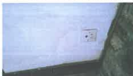
Observation : Prises de courant sans terre, de type pas obturateur et puits inférieur à 15 mm
