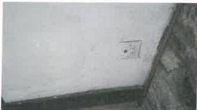
Observation : Prises de courant sans terre, de type pas obturateur et puits inférieur à 15 mm
