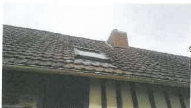
Toiture : Bardages conduit de cheminée en ardoises amiante ciment
